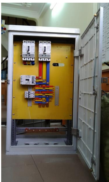
Tủ điện 3 pha lắp đặt điện kế và CB
