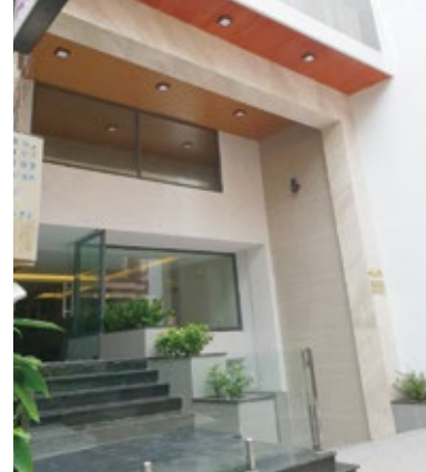
Công trình: Khách sạn Hoa Mộc Lan
