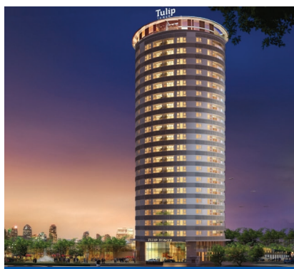
Công trình: TULIP ĐC: 49 Hoàng Quốc Việt - Q. 7 - TP. HCM
